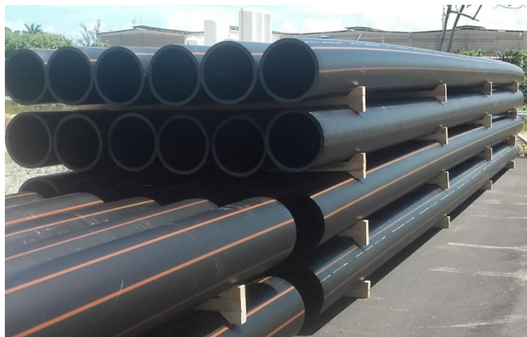
Empilhamento de tubos em barras.
